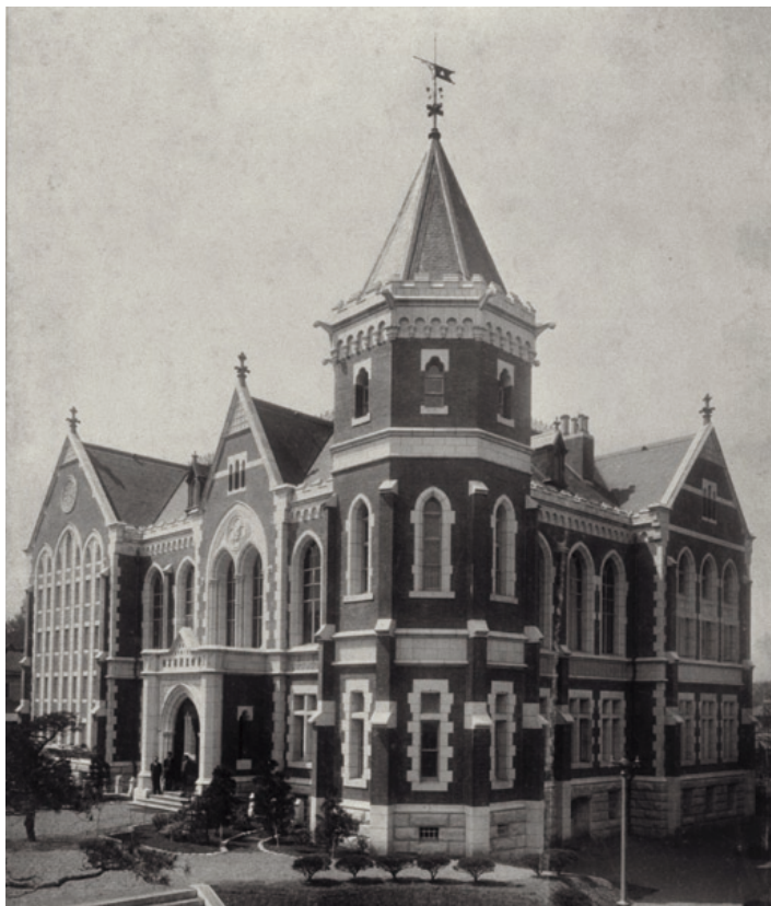
竣工当時の図書館全景 [1912 (明治 45) 年]
